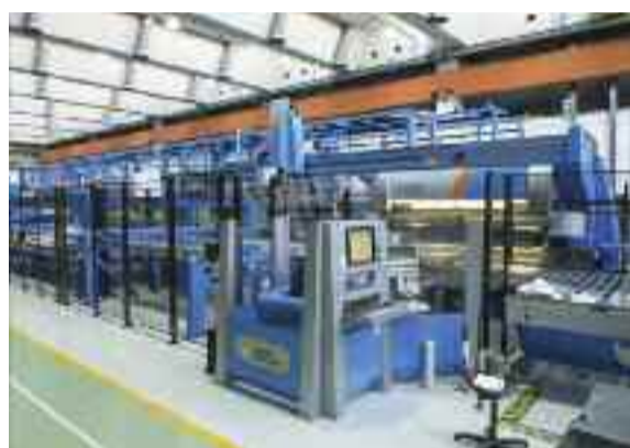
La linea automatica Prima Power per lamiera in ABB Dalmine
