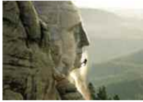
Fase di lavaggio del National Memorial sul Monte Rushmal con tecnologia Kercher.
