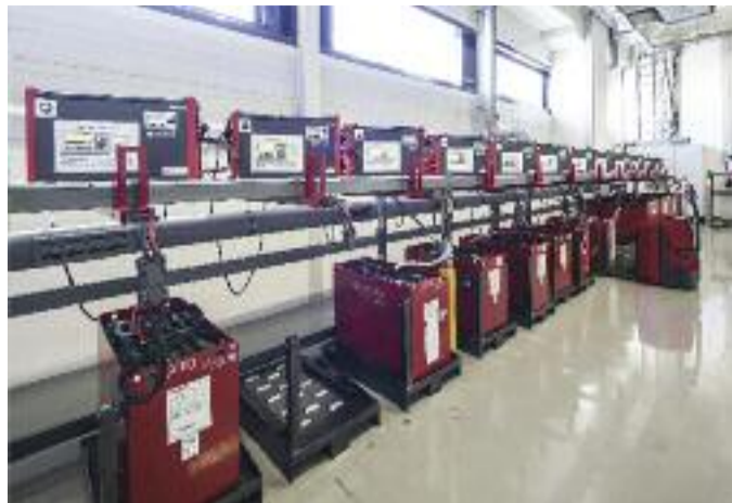
LED di vari colori installati su ogni caricabatteria indicano subito e chiaramente lo stato di carica della batteria collegata: l'arancione indica che la carica è in corso, il verde che la batteria è completamente carica e il blu che la batteria si è raffreddata ed è pronta per l'uso
