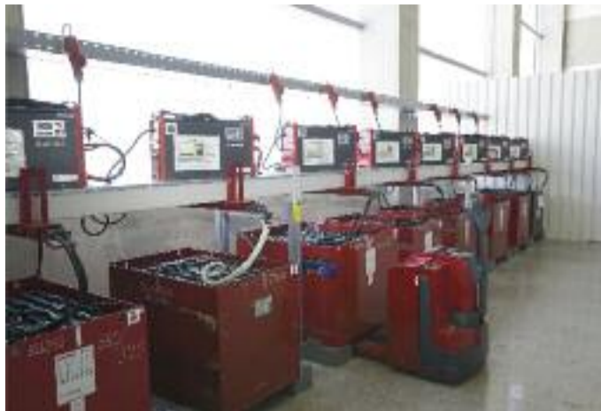
L'innovativo processo di carica Ri degli apparecchi di Fronius riduce al minimo la sovraccarica della batteria, diminuendo il consumo di energia elettrica durante la carica e le emissioni di CO 2
