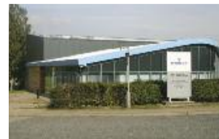
Il nuovo centro ingegneristico regionale a Oradea in Romania
