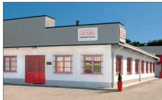
Esterno dello stabilimento CRM a Fino Mornasco.
