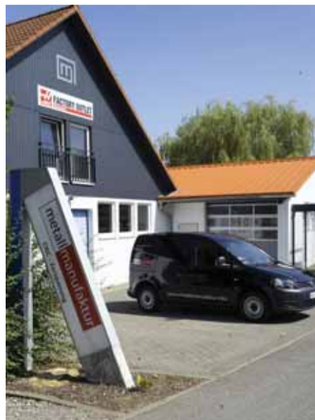
Metallmanufaktur ha recentemente siglato un accordo con il locale Haas Factory Outlet (HFO) Katzenmeier per aprire uno showroom regionale Haas
