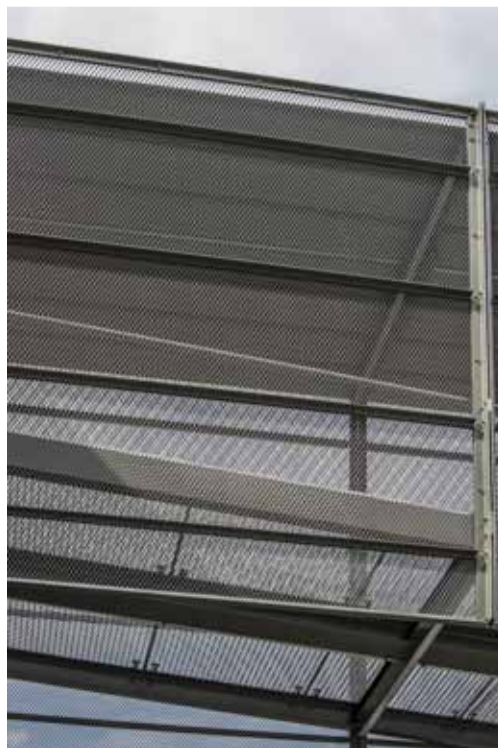
Il passaggio di collegamento tra il centro giovani e un altro edificio dello stadio Audi Sportpark realizzato con lamiera Mevaco
