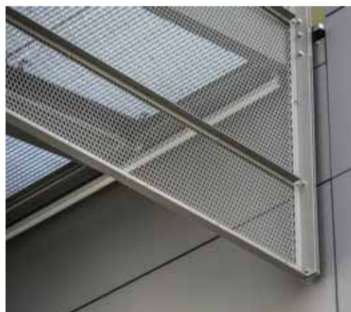
Il passaggio di collegamento tra il centro giovani e un altro edificio dello stadio Audi Sportpark realizzato con lamiera Mevaco
