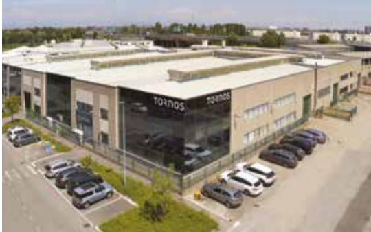
Vista area della sede di Rho di Tornos Technologies Italia
